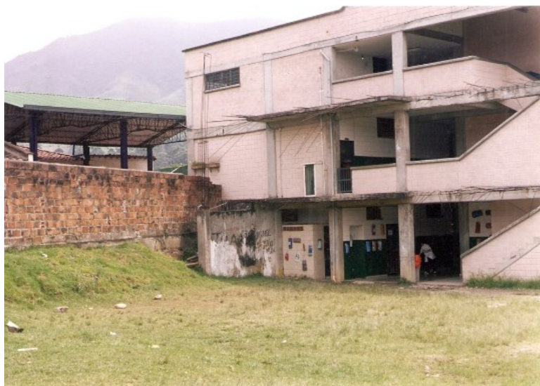
Fachada 2° bloque, vista desde la vía principal
