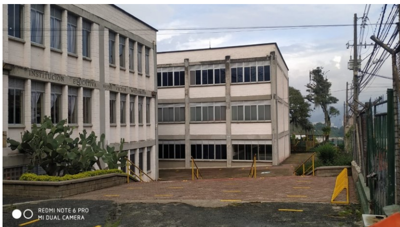
Fachada 1ª y 2º bloques, vista desde la portería
